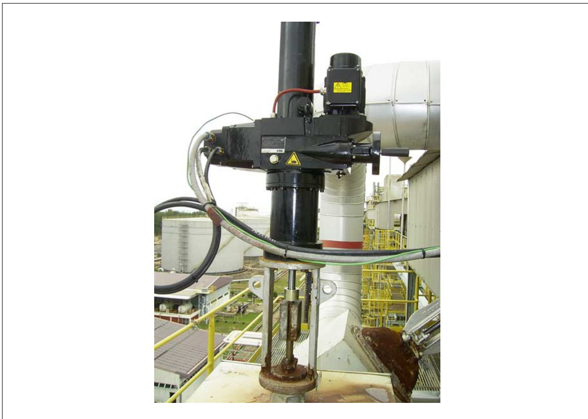
Рис. 2-2: Регулирующий привод непрерывного действия Contrac в смонтированном состоянии
